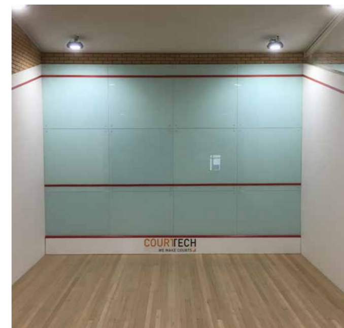
Ремонт фронтальной стены с помощью стекла
