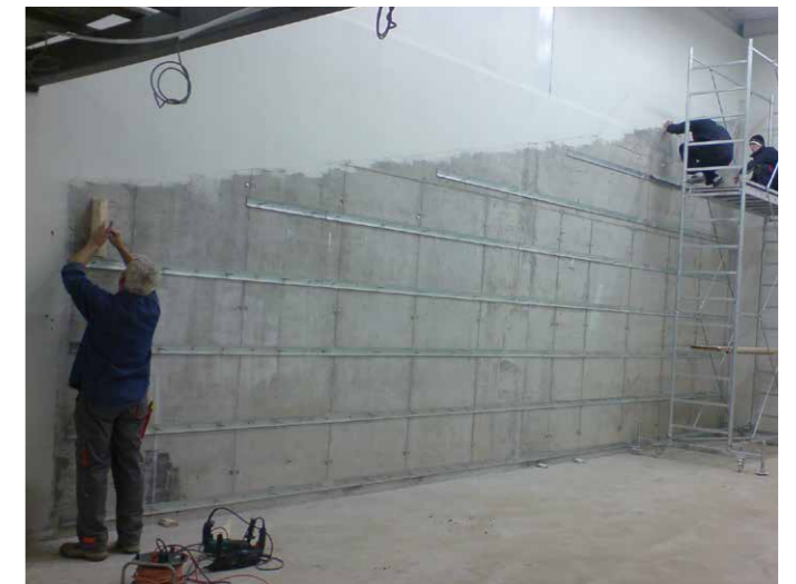
Befestigung der Schienen
