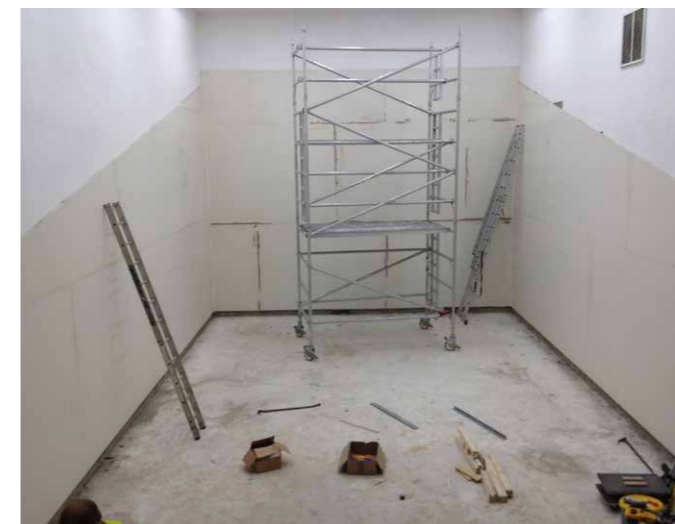
Vor der endgültigen Beschichtung
