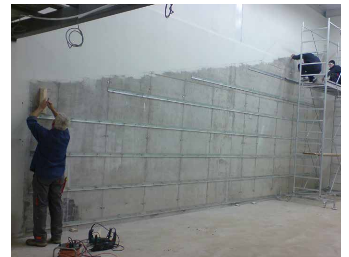
Befestigung der Schienen
