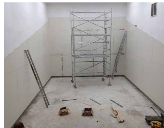
До финишного покрытия
